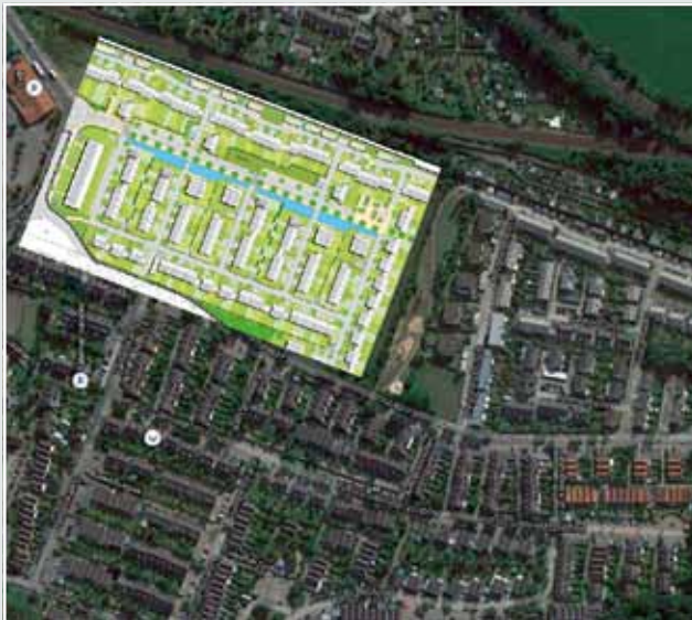
Felderhof 2 fügt sich, wie hier gut zu erkennen ist, in die Umgebungsbebauung ein.
