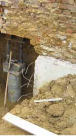
Mitte & rechts: Wenn die Bodenplatte fehlt: Einsatz hochmoderner Presspfahltechnik in Aachen, um die Fundamente des alten Kutschergebäudes nachhaltig sicher nachzugründen.
