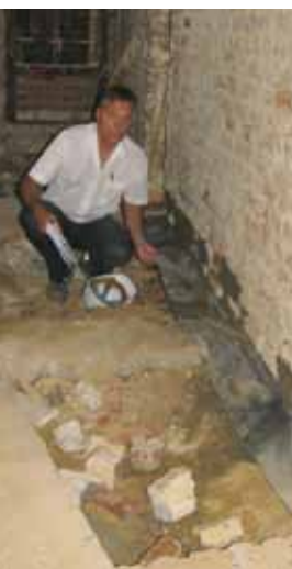
Mitte: Für den Feuchtigkeitsschutz wird das alte Mauerwerk durchgesägt und eine Kunstfaserplatte eingefügt.
